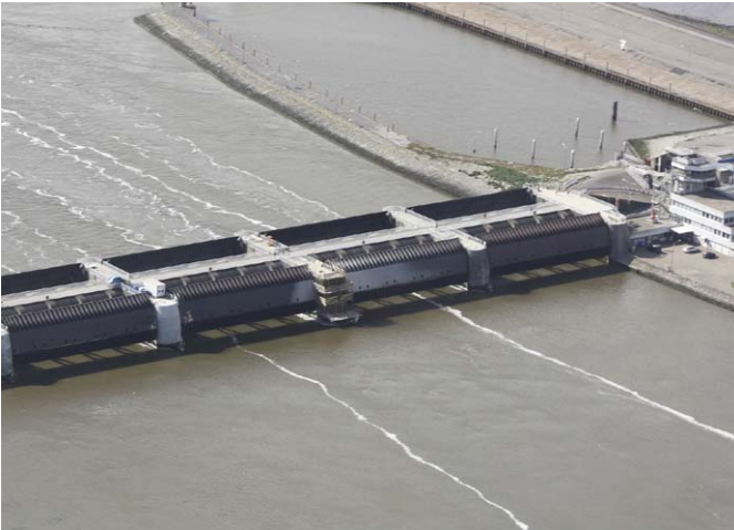
Abb. 1 Beispiel einer Personen-Notsignal-Anlage: Eidersperrwerk mit Wehrantriebsräumen
