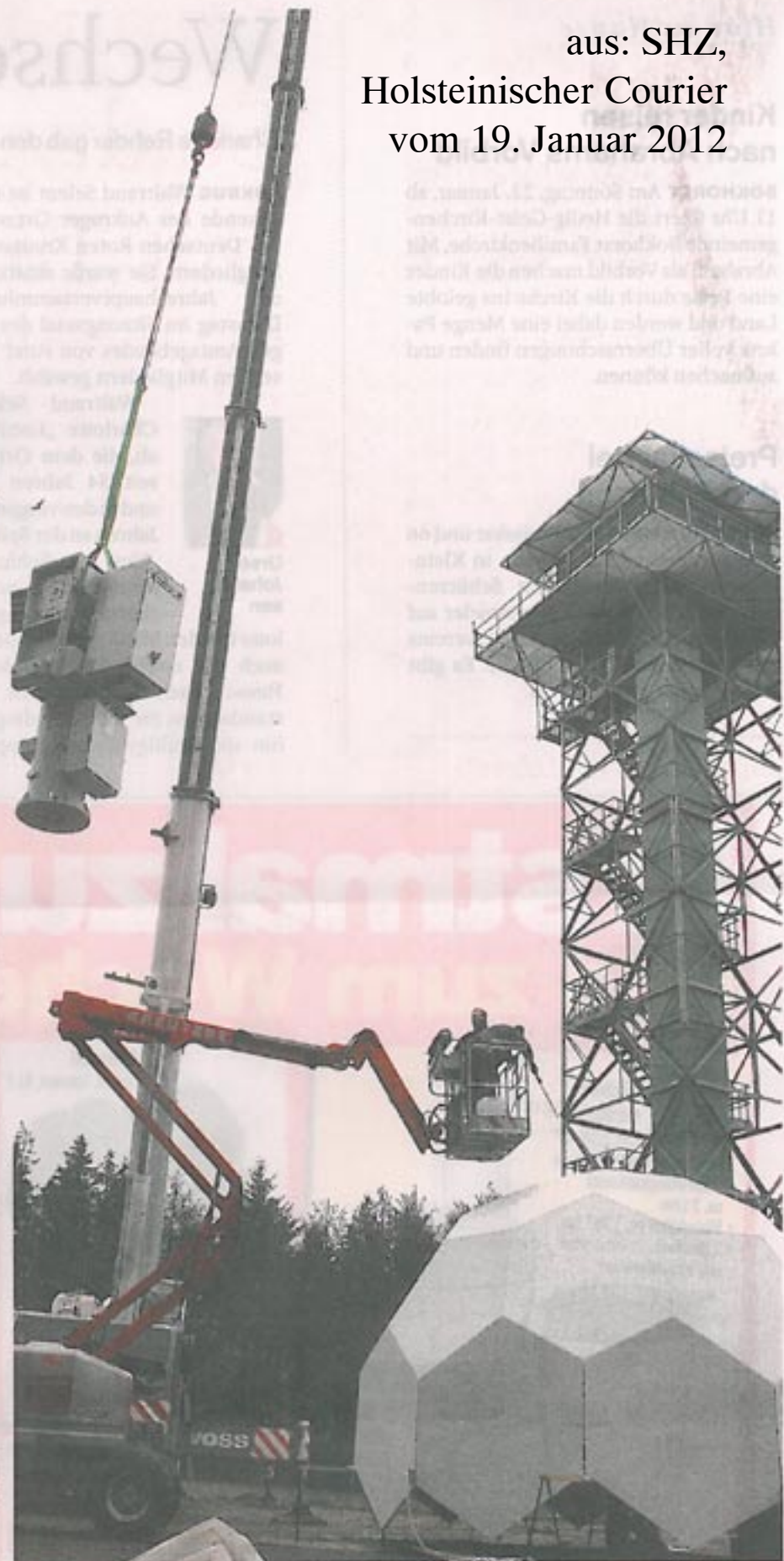
800 Kilo schwer ist der Drehturm für die Antenne, der hier per Kran nach oben befördert wird. Im Vordergrund liegt die Schutzhülle für die Antenne. BÖGE (3)
