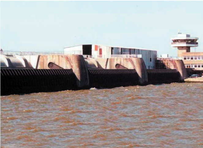
Abb. 1 Beispiel einer Personen-Notsignal-Anlage: Eidersperrwerk mit Wehrantriebsräumen
