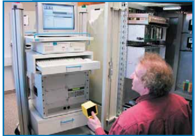
Spannungsprüfung der Schaltschränke
