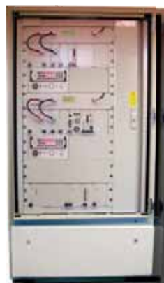
Gleichwellen-Funkschränke
