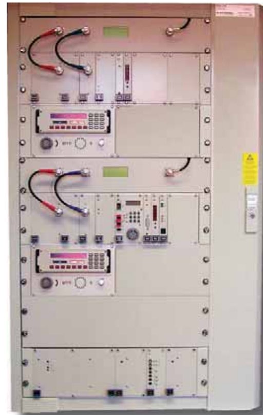
Beispiel: FSO-BOS Gleichwellen-Funkschrank
