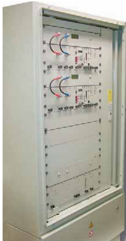
BOS - Gleichwellenschfunktank
